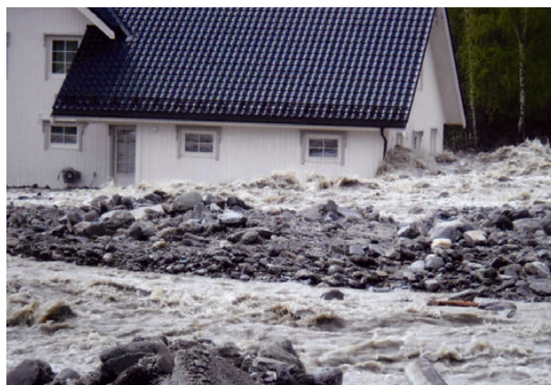
I 2013 ble det andre huset, bygget på samme sted, tatt av flommen. (Foto: Privat)
